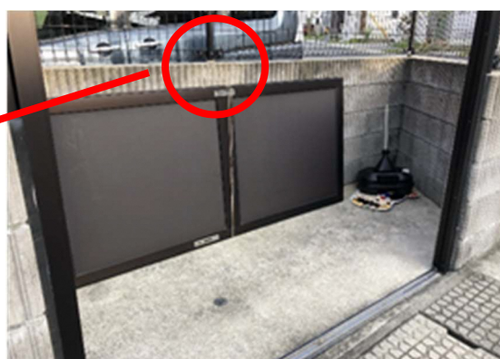
紐で結んだ扉2枚を、GS内のブロックに たてかけ、GS金属支柱に紐で結びつける (固結び)
