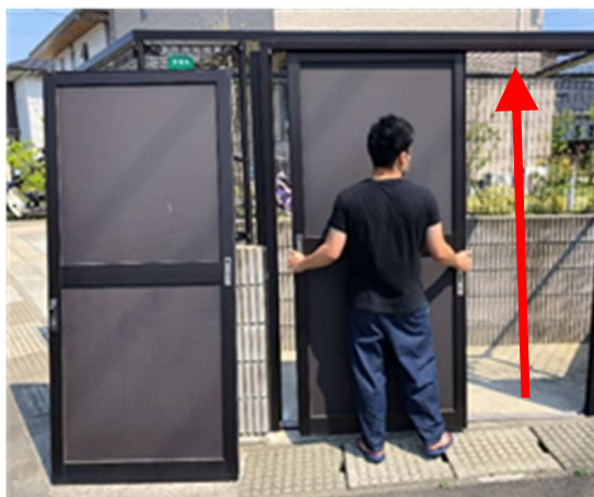
扉を1枚ずつはずす (上に少し持ち上げ、下端からずらす)
