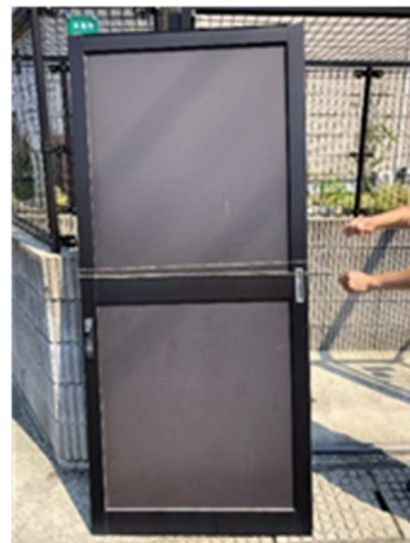
はずした扉を2枚重ねて、紐で結ぶ (固結び)
